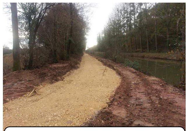
Travaux de terrassement : la voie à vélo bientôt opérationnelle
