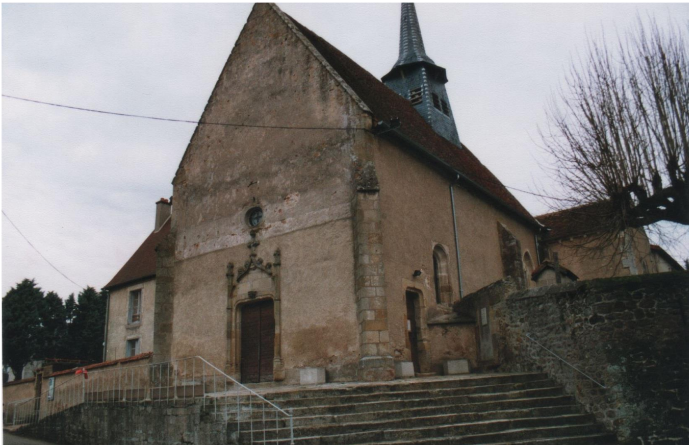
la façade avant
