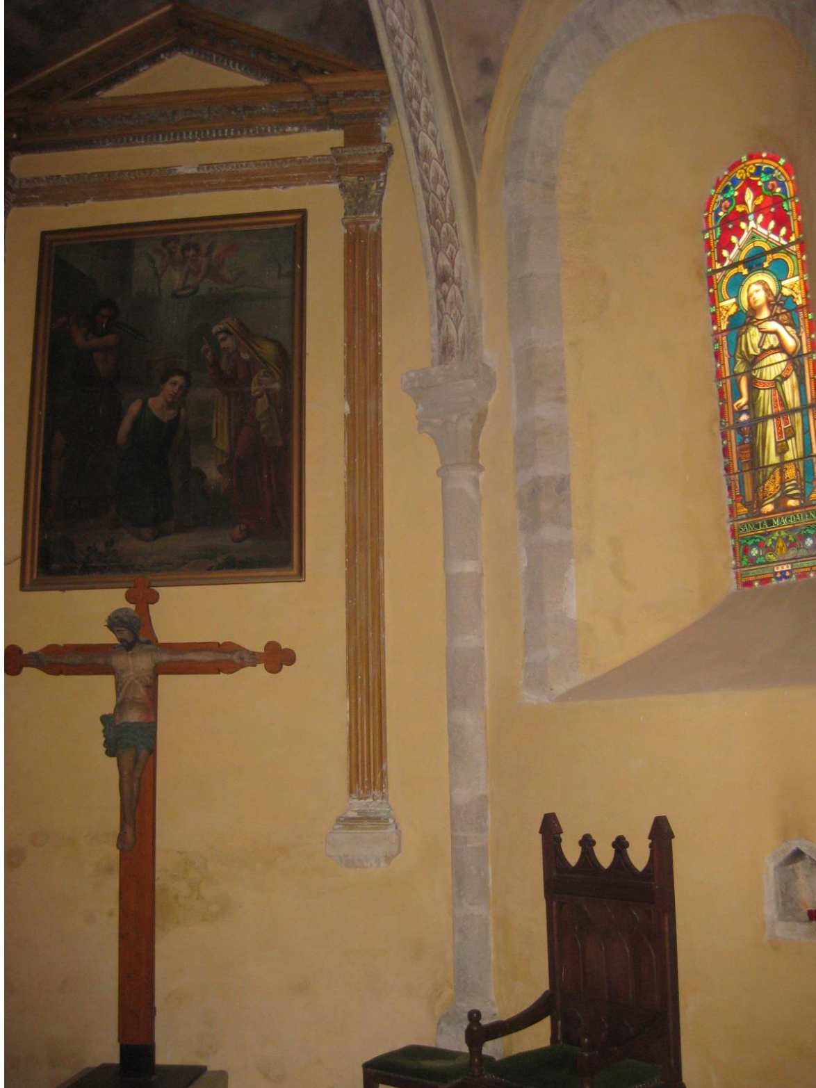
Les nouveaux enduits du chœur
