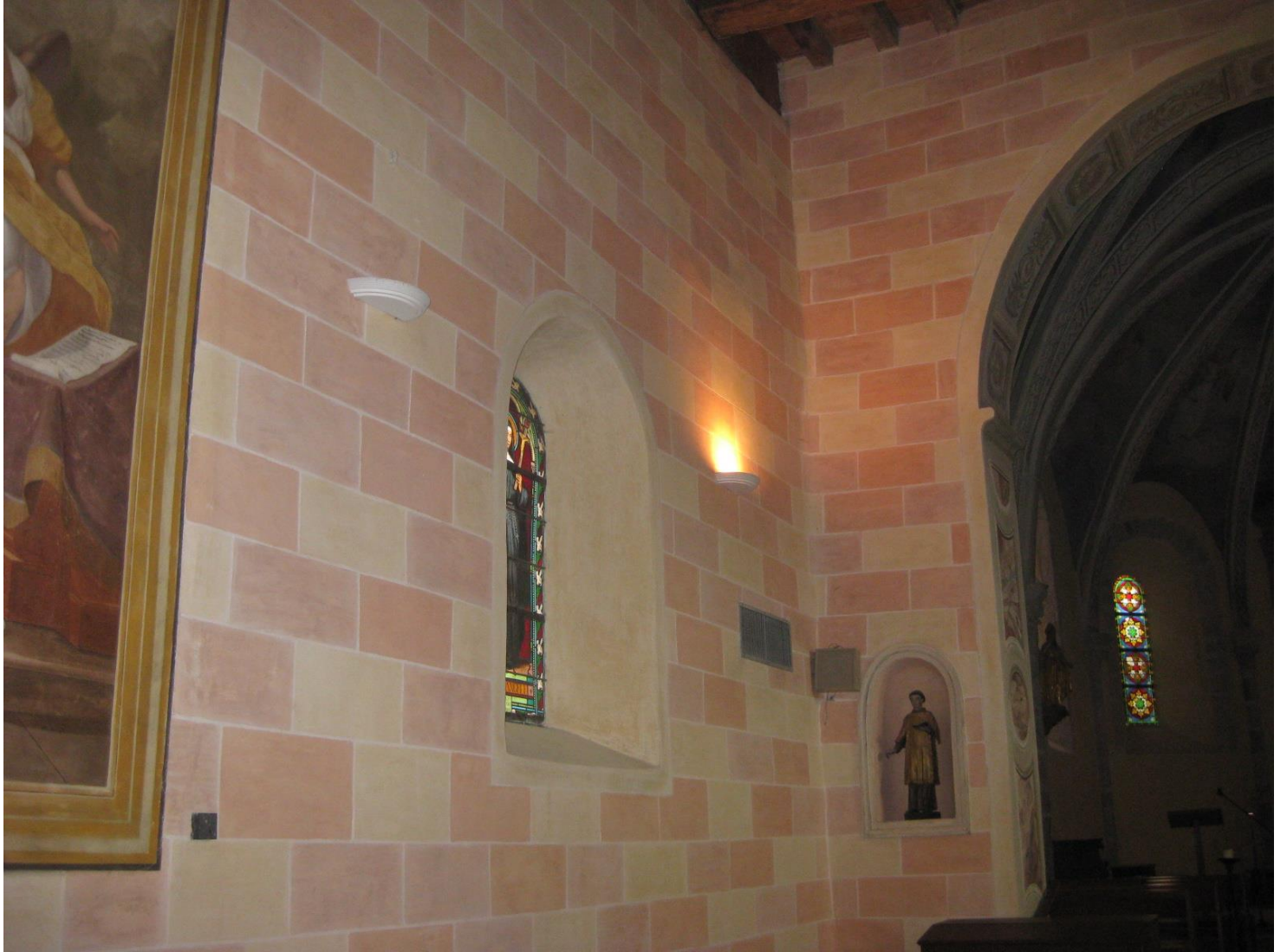
Les nouveaux enduits
