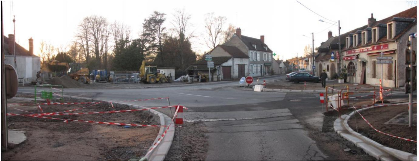
Après un mois d'interruption, en raison de la nécessité d'effectuer de nouveaux relevés de surface, les travaux ont repris par l'implantation des bordures offrant **des trottoirs plus larges**. Tous les réseaux aériens seront enterrés et les places de stationnement partiellement modifiés pour des raisons de sécurité. Ainsi, les places en épi doivent être abandonnées pour des stationnements classiques le long de la chaussée.
