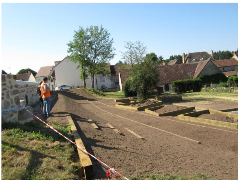
Travaux au jardin de la cure
